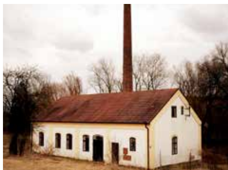
Čerpací stanice, pohled ze severozápadu
